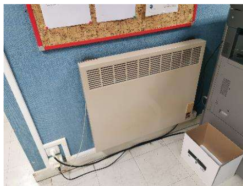
Chauffage par convecteurs électriques d'une ancienne génération
