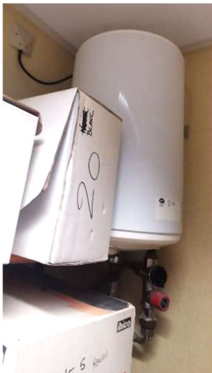
Chauffe-eau électrique dédié à l'alimentation ECS d'un lavabo
