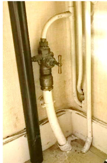
Arrivée générale eau potable située dans le local rangement attenant aux sanitaires
